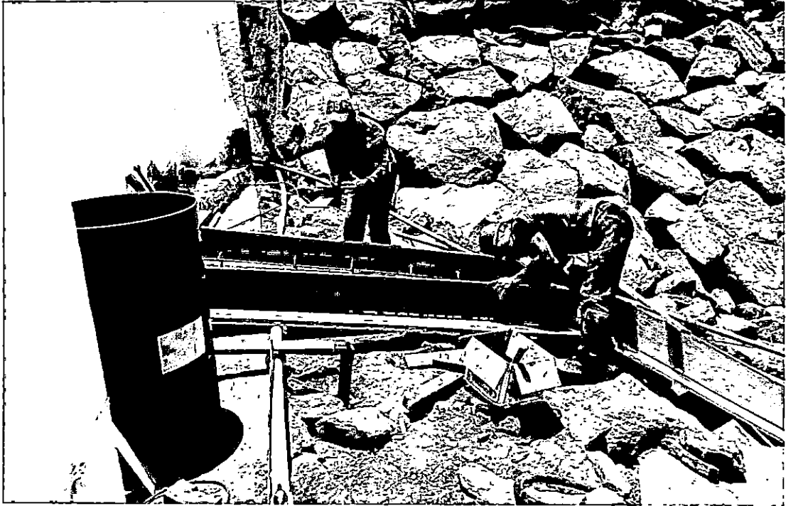
Fotografía N°05: Vista de encofrado de fijación de primeros metros de emisor submarino.
