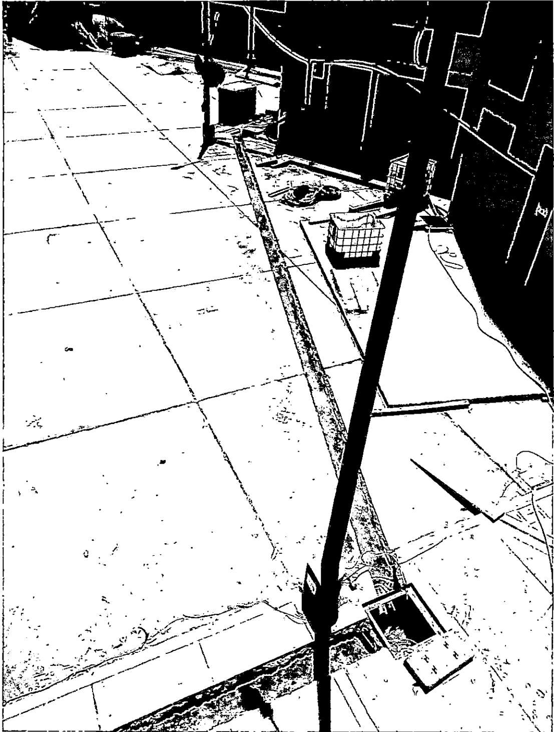
Fotografía N°14: Vista de pisos demolidos para canalización eléctrica.
