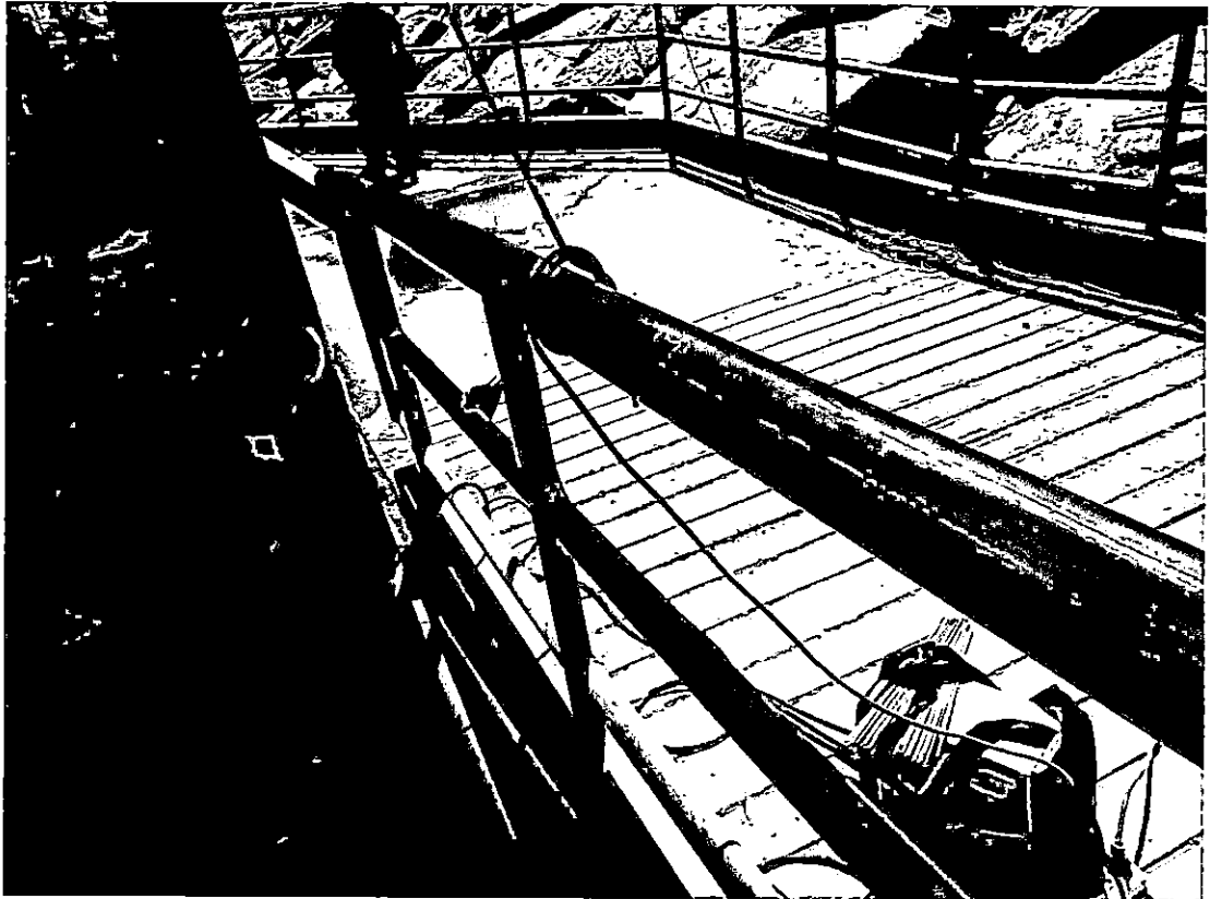
Fotografía N°06. Vista de culminación de barandas en muelle marginal por parte de FONDEPES.
