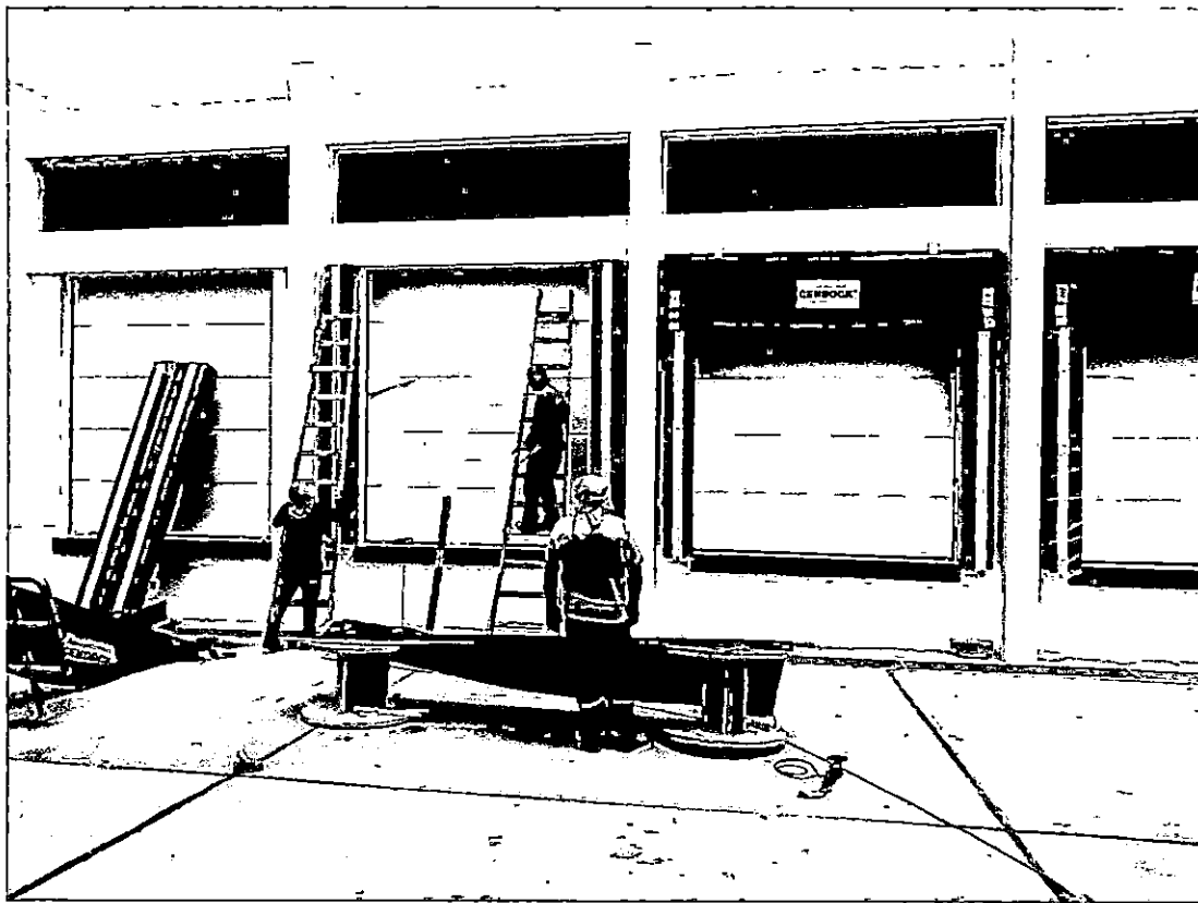
Fotografía N°09: Vista de instalación de abrigos retráctiles.
