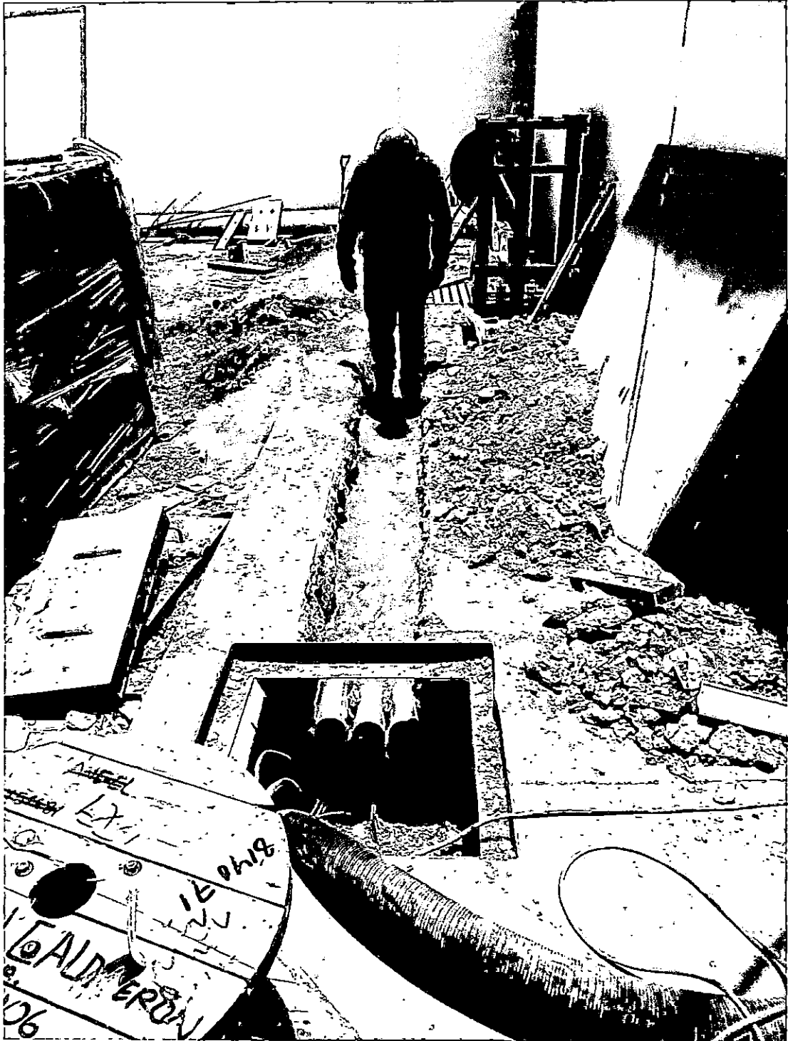
Fotografía N°04: Vista de ductos agregados en canalización eléctrica.
