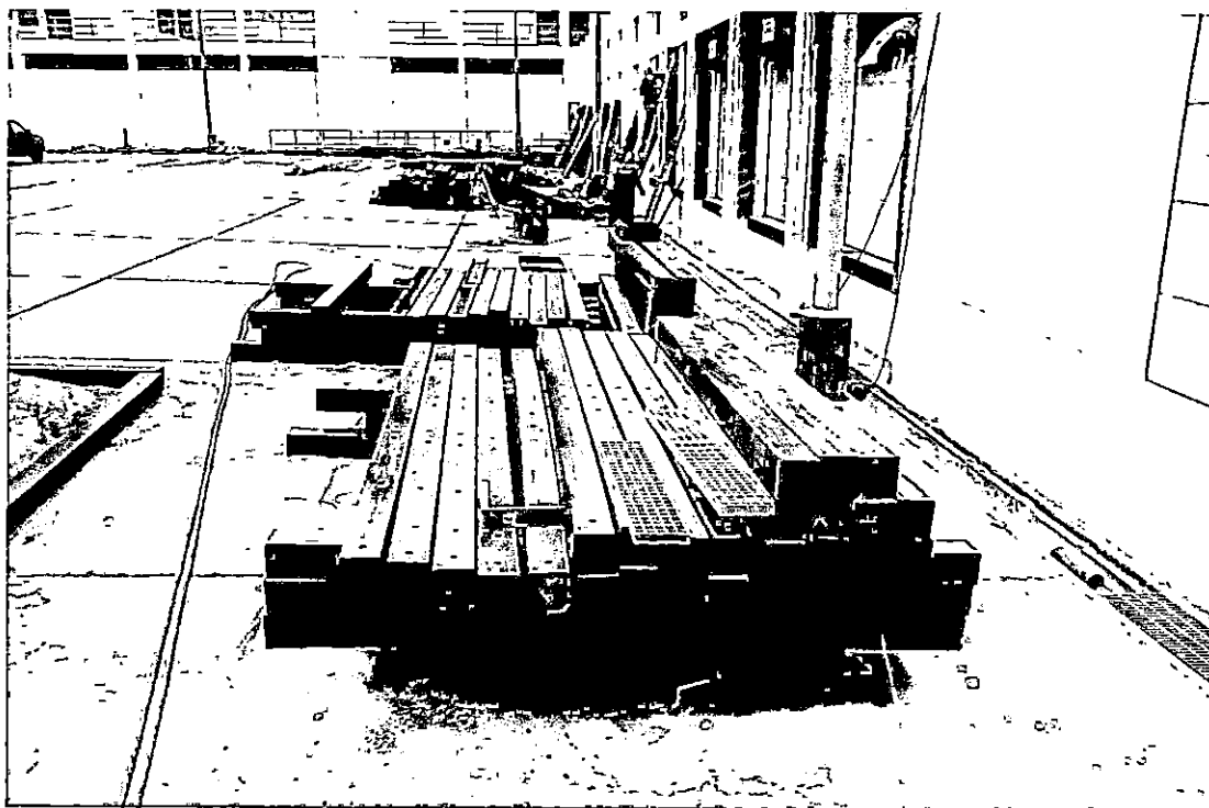
Fotografía N°08: Vista de madera para defensa de muelles que no ha sido instalada.
