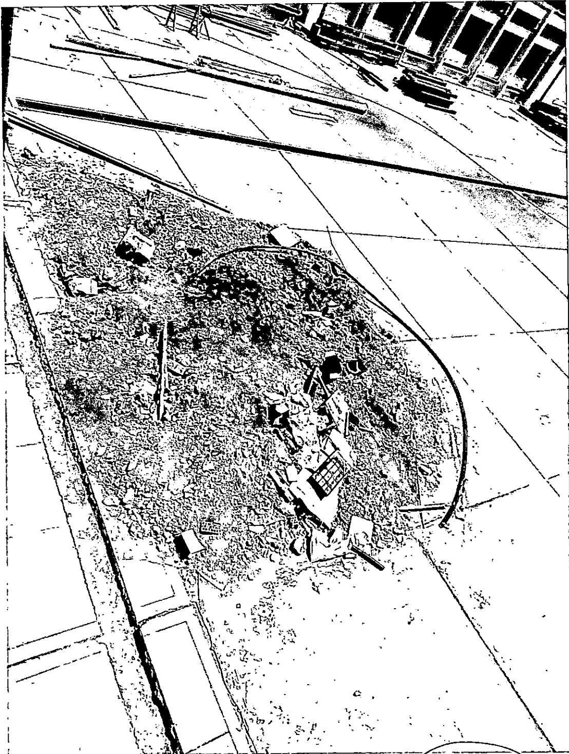
Fotografía N°15: Vista de vaciado de pisos en área de frío.
